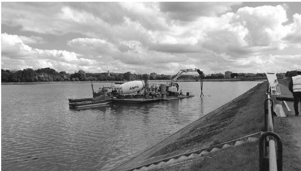
Projekt i wykonanie „Odtworzenie szczelności obwałowania ziemnego Orzepowice w PGE GiEK Oddział Elektrownia Rybnik”
